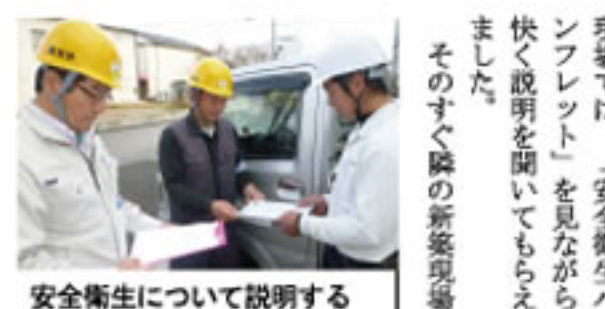
安全衛生について説明する
