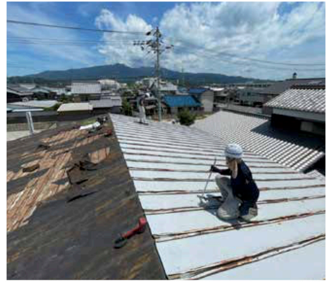
屋根一面の錆びたトタンをはがす
